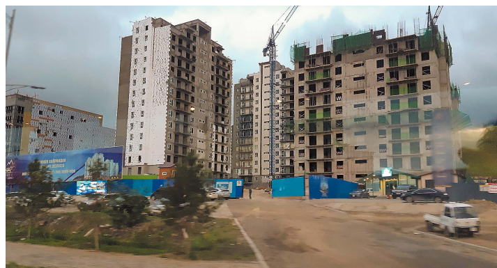
写真3 建設中のビル（ウランバートル）
