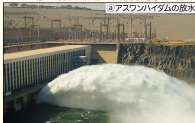
①アスワンハイダムの放水
