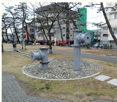
写真1 防火用水槽の消火栓
